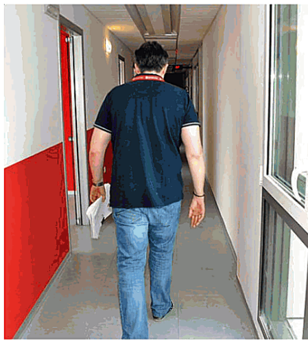
L'ospedale allagato dopo la rottura di un giunto nell'impianto idraulico
