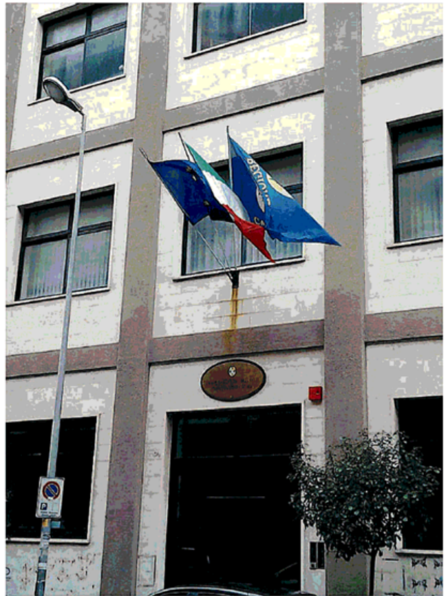
Il Dipartimento. Negli uffici di via Buccarelli, a Catanzaro, vi è la sede della Struttura commissariale
