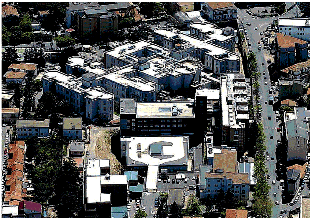
La cittadella ospedaliera dell'Annunziata. Scattano i nuovi orari di servizio dei medici e l'assistenza potrebbe andare in crisi
